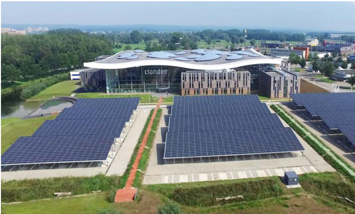
7. Liander, Zonnepanelen op parkeerdek en fietsenstalling ( www.deingenieur.nl )
