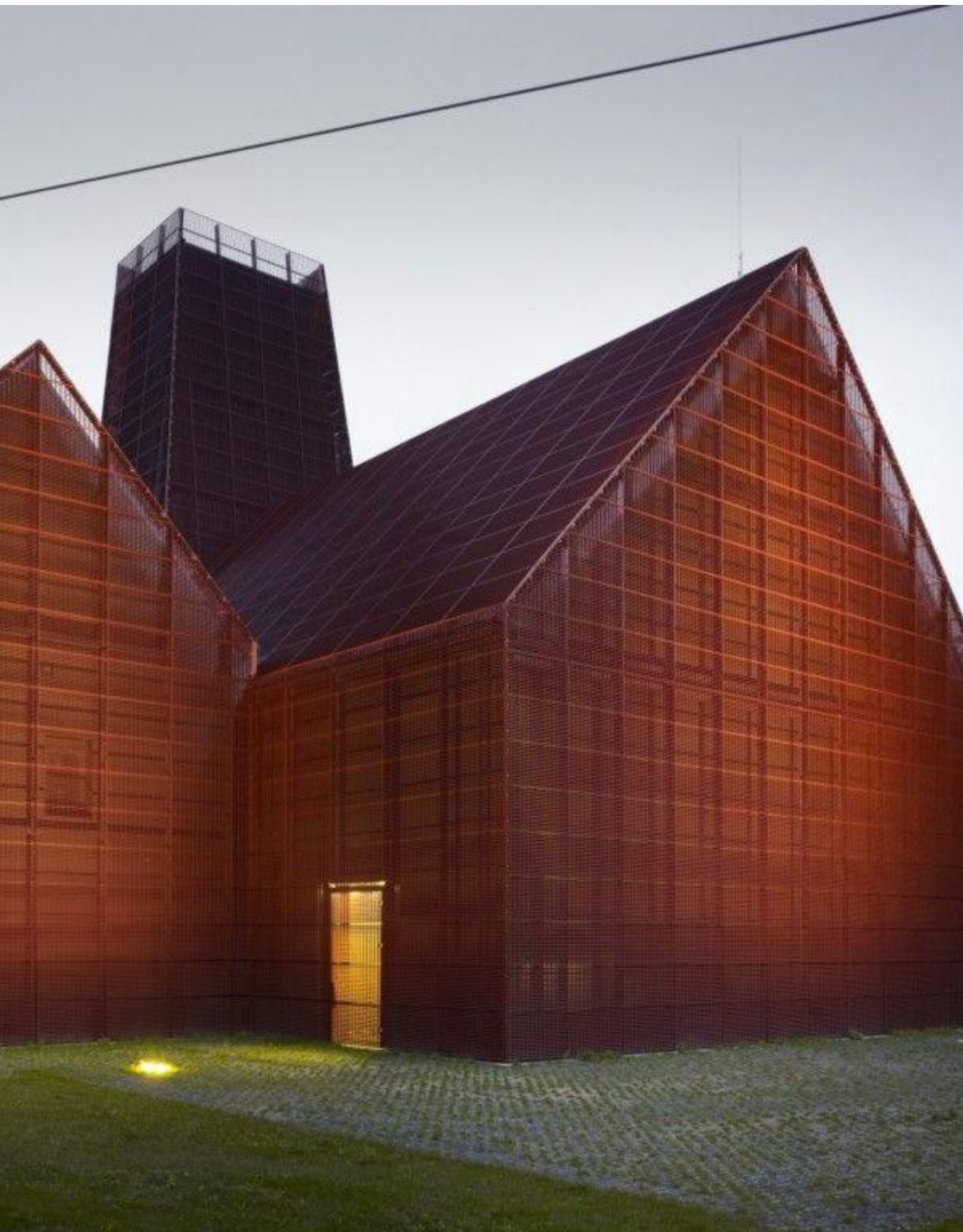
12. Aardwarmtecentrale, Den Haag ( www.architectuur.nl )
