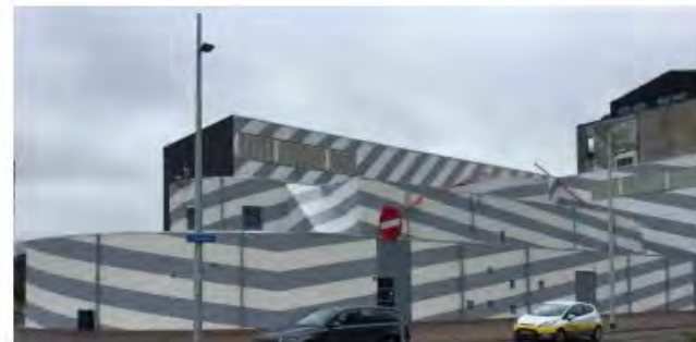
TS-MS station (van 25-66 naar 3-23 kV)
