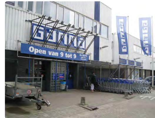
... en bouwmarkten aan de Ambachtsweg
