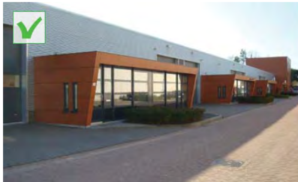
courant geschakelde units
