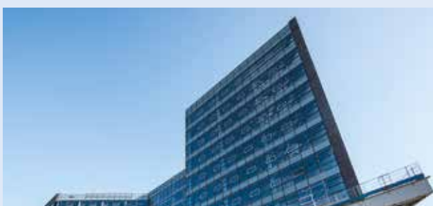
De nieuwbouw voor Heerema. Het oude gebouw van Heerema, dat sinds 2007 leeg stond, is gesloopt.
