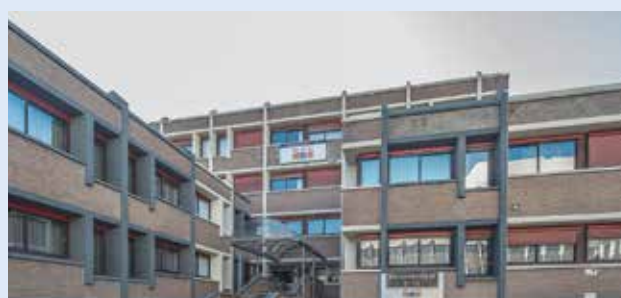
Verbeekstraat. Dit kantoor is in 2014 vooral intern verbouwd naar woningen voor expats.
