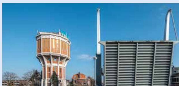
De monumentale watertoren aan de Hoge Rijndijk heeft een nieuwe functie als woning en kantoor gekregen.
