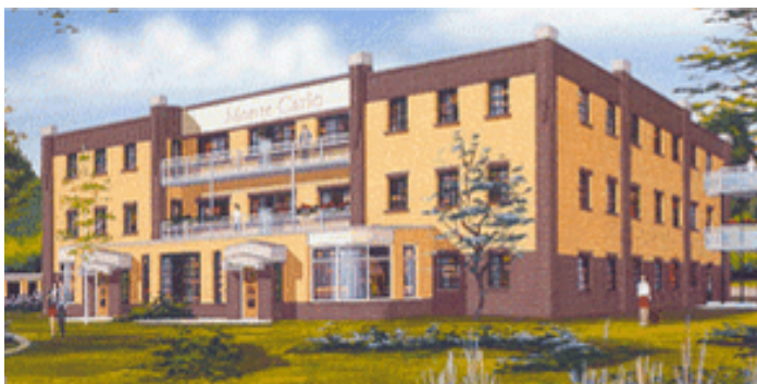
Woonappartementen (Teylingerlaan Sassenheim)
