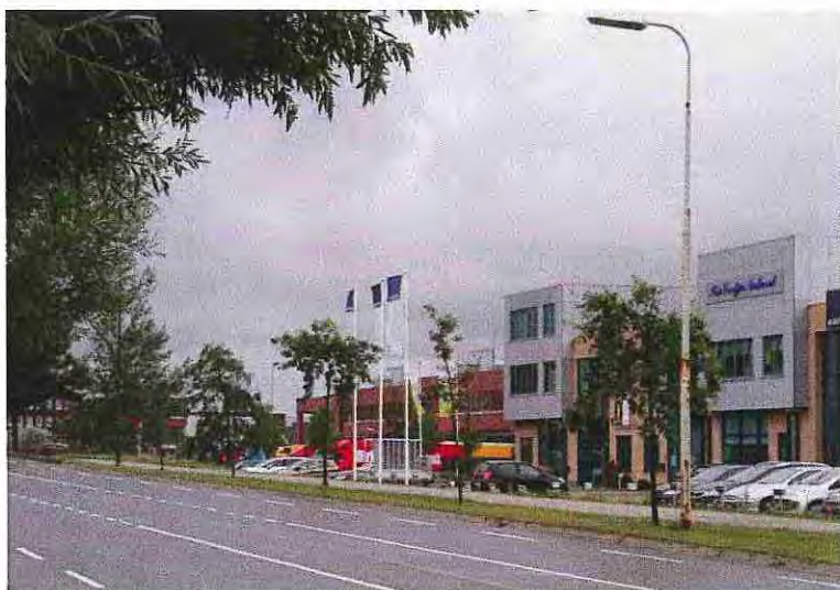
Foto 14a. Nulsituatie Rijksstraatweg deel 2
