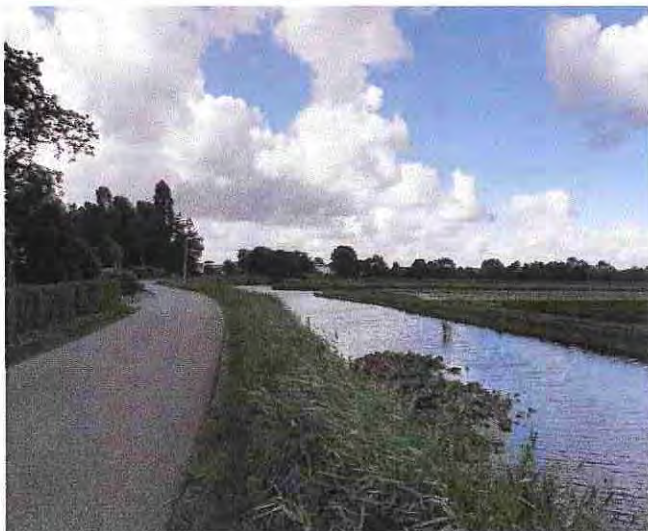
Foto 7a. Nulsituatie Zandlaan
